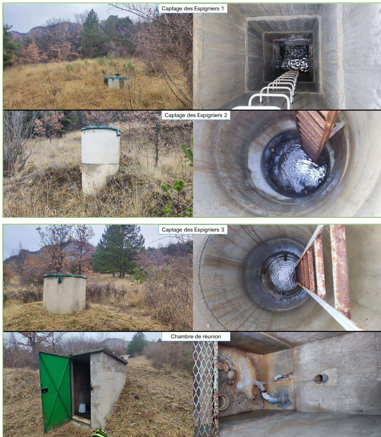
Figure 58 : photographies des ouvrages du captage des Espigniers
