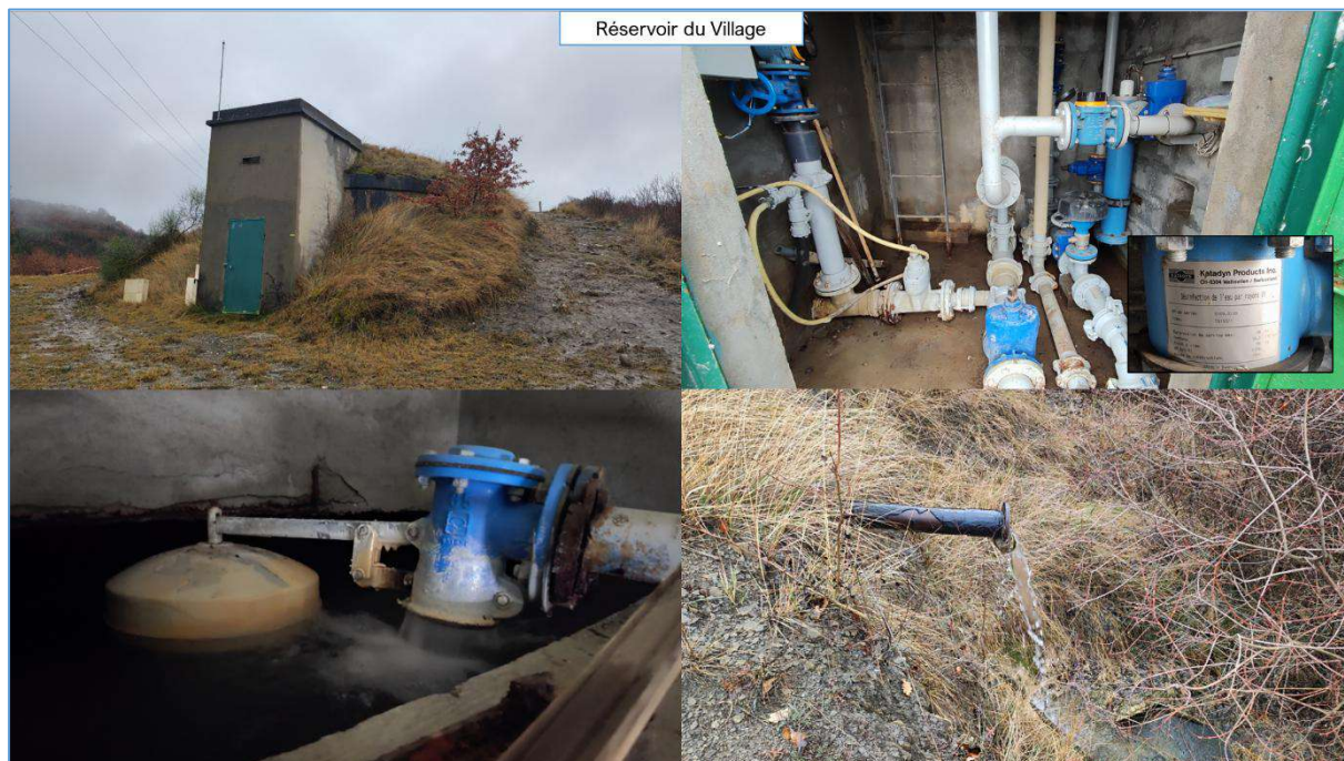
Figure 5 : photographies du réservoir du Village
