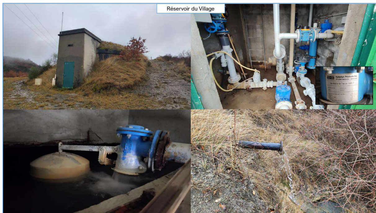
Figure 42 : photographies du réservoir du Village
