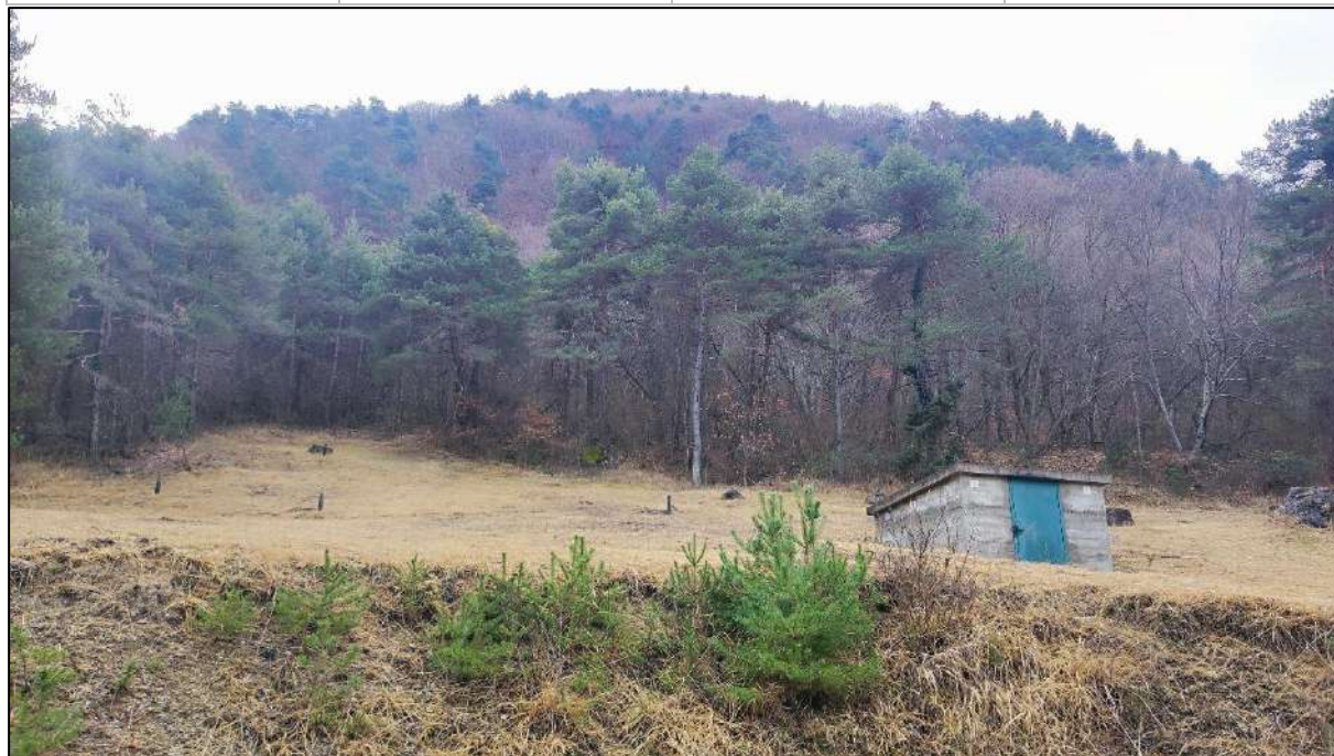
Figure 17 : photographie du captage de la source de la Brunette
