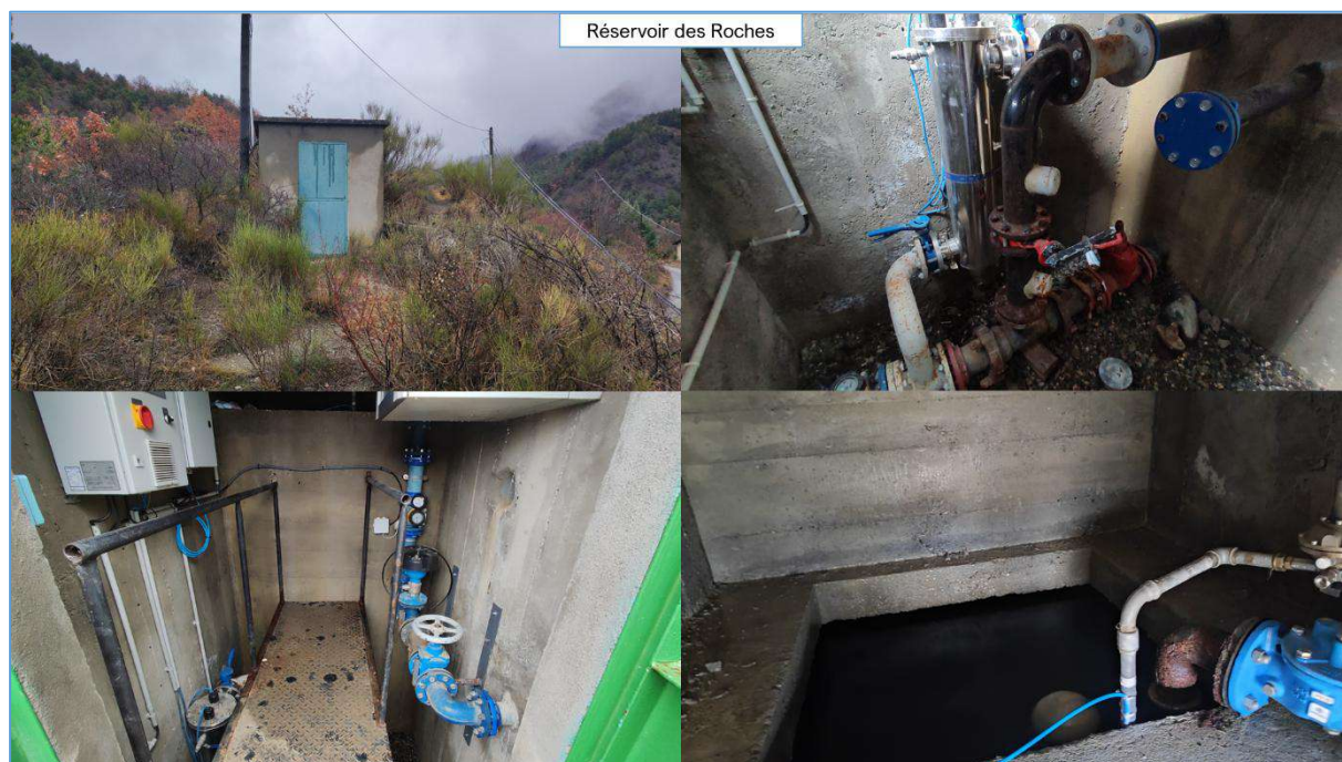
Figure 41 : photographies du réservoir des Roches
