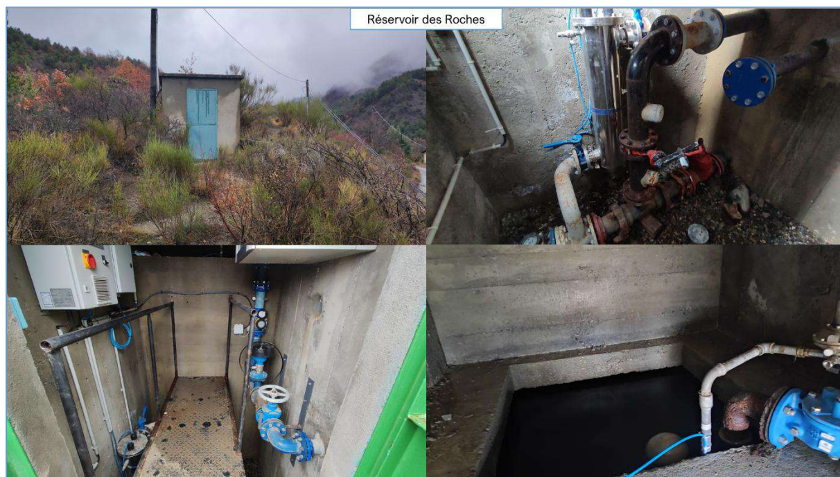
Figure 4 : photographies du réservoir des Roches
